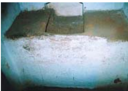
ရွှံ့အိမ် - အမြင့် = ၁.၅ မီတာ၊ အကျယ် = ၂ မီတာ၊ ဝင်ဆန့်မှု = ၅၀၀ ကီလိုဂရမ်ကျော်
