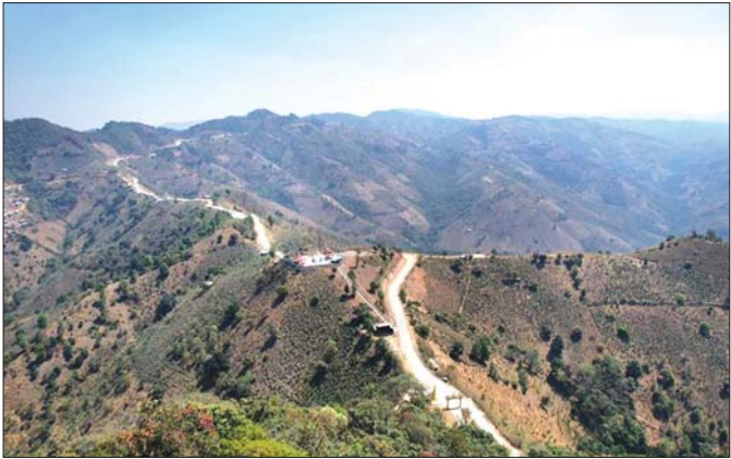
နယ်စပ်ရေးရာဝန်ကြီးဌာနက ကျောက်ခင်းလမ်းအဖြစ် အဆင်ပြေတင် ဆောင်ရွက်ပေးခဲ့သည့် ကလော မြို့နယ် တာယော- ရွာသစ်- ညောင်ကုန်း- ရွှေမင်းဖုန်းဘုရား- အလယ်ရွာ- ဆော်တောရွာ-တောင်ပုံ ကျေးရွာချင်းဆက်လမ်းကို တွေ့မြင်ရစဉ်။
