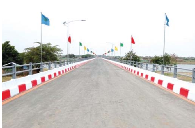
လယ်ဝေးမြို့နယ် ရုံးပင်-အေးချမ်းသာ ကွန်ကရစ်တံတား တည်ဆောက်ခြင်း
