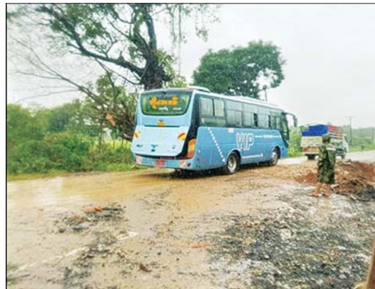
တံတားပြင်ဆင်ပြုပြင်ပြီး မော်တော်ယာဉ်များ ပြန်လည်ဖြတ်သန်းသွားလာနေသည့် မှတ်တမ်းဓာတ်ပုံ။
