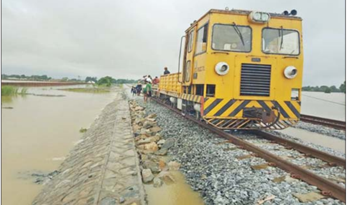
ရန်ကုန်-မန္တလေးရထားလမ်းပိုင်း၊ ပဲခူး-ရွှေလှေအကြား ရထားလမ်းတာပေါင် ရေတိုက်စားထားသော နေရာများအား ကျောက်ကြီးများ ချယူထည့်ပြုပြင်နေမှုကို တွေ့ရစဉ်။
