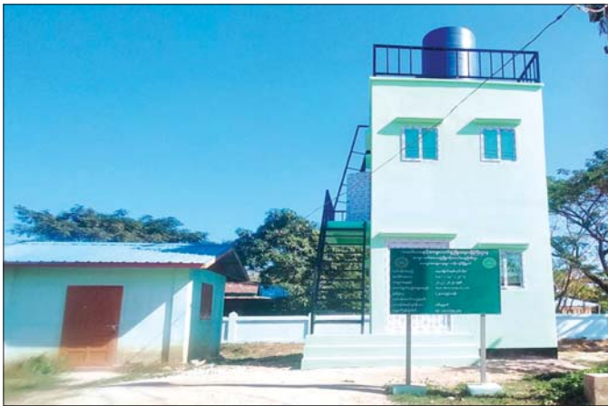
ဖားကူးကျေးရွာ ရေသန့်စင်စနစ်ဆောင်ရွက်ထားရှိမှုကို တွေ့ရစဉ်။
