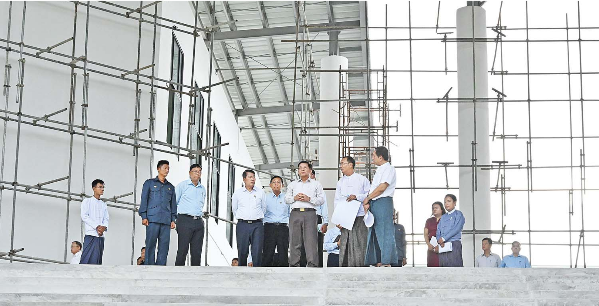
နိုင်ငံတော်စီမံအုပ်ချုပ်ရေးကောင်စီဥက္ကဋ္ဌ နိုင်ငံတော်ဝန်ကြီးချုပ် ဗိုလ်ချုပ်မှူးကြီးမင်းအောင်လှိုင် ရန်ကုန်အနောက်ပိုင်းနည်းပညာတက္ကသိုလ်အတွင်း စာသင်ဆောင်အသစ်ဆောက်လုပ်နေမှုများကို လှည့်လည်ကြည့်ရှုစစ်ဆေးစဉ်။
