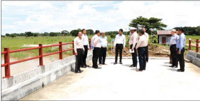
လေးမျက်နှာမြို့နယ် ခုကြီး-ခတ္တရလမ်းပေါ်၌ တံတားတည်ဆောက်မှုကို ကြည့်ရှုစဉ်။
