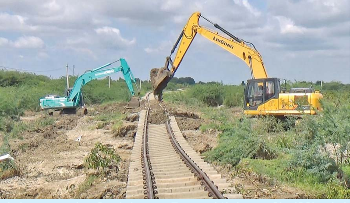
ရန်ကုန်-မန္တလေးရထားလမ်း၊ သပြေတောင်းနှင့် စမုံဘူတာအကြား ရထားလမ်းပိုင်းနှင့်တံတားများပြန်လည်ပြုပြင်ဆောင်ရွက်နေမှုအခြေအနေကိုတွေ့ရစဉ်။
