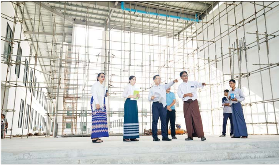
Multipurpose Hall Structure System တို့ကို ကြည့်ရှုစစ်ဆေးသည်။
