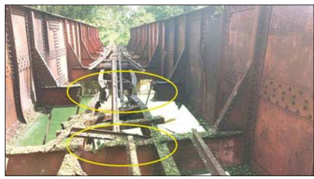
ရေး-ထားဝယ်ရထားလမ်းပိုင်းအတွင်း ထားဝယ်မြို့နယ် ရေဖြူနှင့် ထားဝယ်ဘူတာကြား တံတားအမှတ်(၆၀၆) မောင်မယ်ရောင်တံတား မိုင်းခွဲဖျက်ဆီးခံထားရမှုအခြေအနေ။
