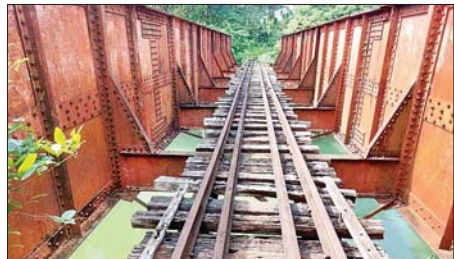
ရေး-ထားဝယ်ရထားလမ်းပိုင်းအတွင်း ထားဝယ်မြို့နယ် ရေဖြူနှင့် ထားဝယ်ဘူတာကြား တံတားအမှတ်(၆၀၆) မောင်မယ်ရောင်တံတား မိုင်းခွဲဖျက်ဆီးခံထားရမှုအခြေအနေ။
