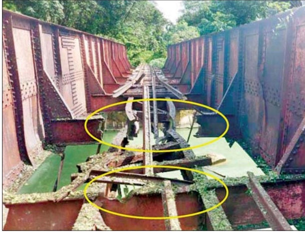
ရေး-ထားဝယ်ရထားလမ်းပိုင်းအတွင်း တနင်္သာရီတိုင်းဒေသကြီး ထားဝယ်မြို့နယ် ရေဖြူနှင့် ထားဝယ်ဘူတာအကြား တံတားအမှတ် (၆၀၆) မောင်မယ်ရှောင်တံတား မိုင်းခွဲဖျက်ဆီးခံထားရမှုမှတ်တမ်း ဓာတ်ပုံများ။
