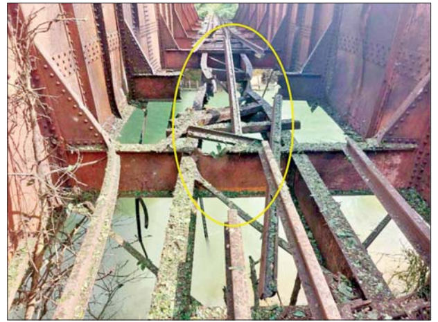
ရေး-ထားဝယ်ရထားလမ်းပိုင်းအတွင်း တနင်္သာရီတိုင်းဒေသကြီး ထားဝယ်မြို့နယ် ရေဖြူနှင့် ထားဝယ်ဘူတာအကြား တံတားအမှတ် (၆၀၆) မောင်မယ်ရှောင်တံတား မိုင်းခွဲဖျက်ဆီးခံထားရမှုမှတ်တမ်း ဓာတ်ပုံများ။
