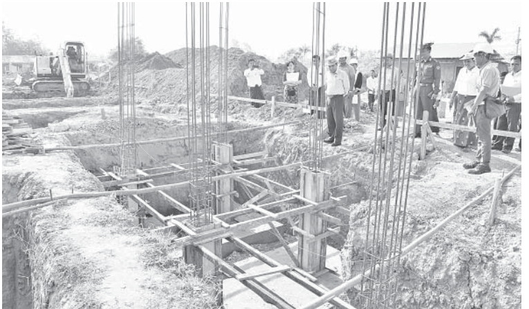
အဆောက်အအုံ အပျိုဆောင်တစ်လုံးများကို တာဝန်ရှိသူများအား မှာကြားခဲ့တည်ဆောက်နေမှု အခြေအနေများကို ကြောင်း သိရသည်။ လှည့်လည်ကြည့်ရှုစစ်ဆေးပြီး လိုအပ်သည် (သတင်းစဉ်)
