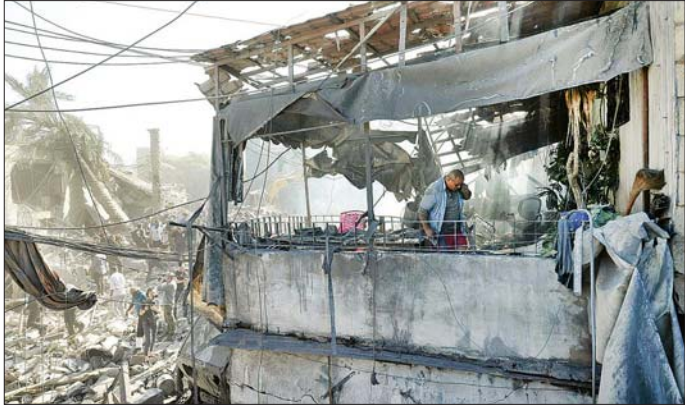
ဘေရွတ်မြို့ ဂျနာဒေသသို့ အစ္စရေးလေကြောင်းတိုက်ခိုက်မှုကြောင့် ထိခိုက်ပျက်စီးမှုများကို တွေ့ရစဉ်။
