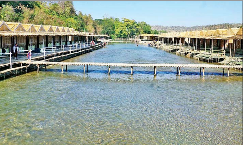
မန်းရွှေစက်တော်ဘုရားပွဲတော်သို့ လာရောက်ကြမည့် ရဟန်းရှင်လူများ တည်းခိုနိုင်ရန် ဆောက်လုပ် ထားသည့် တည်းခိုဆောင်များကို တွေ့ရစဉ်။
