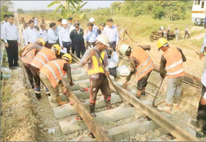
ဒုတိယဝန်ကြီးချုပ်နှင့် ပြည်ထောင်စုဝန်ကြီး ဗိုလ်ချုပ်ကြီး မြထွန်းဦး ရထားများ မိုင်နှုန်းတိုးမြှင့် ဖြတ်သန်းနိုင်ရေးအတွက် သစ်သားဇလီဖားအဟောင်းများအစား ခေတ်မီ Synthetic Sleeper အသစ်များဖြင့် လဲလှယ် နေမှုကို ကြည့်ရှုစစ်ဆေးစဉ်။
