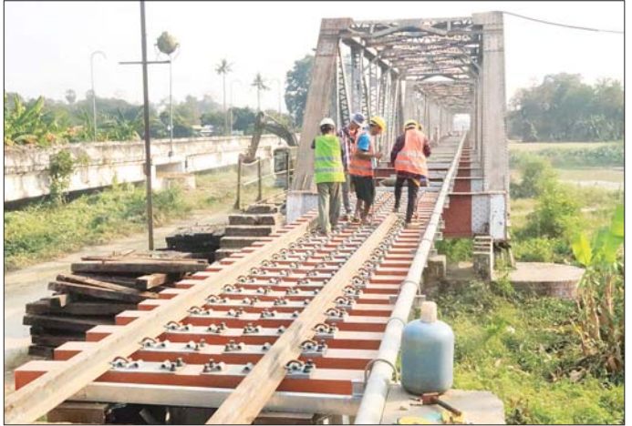
ဒုတိယဝန်ကြီးချုပ်နှင့် ပြည်ထောင်စုဝန်ကြီး ဗိုလ်ချုပ်ကြီး မြထွန်းဦး ရထားများ မိုင်နှုန်းတိုးမြှင့် ဖြတ်သန်းနိုင်ရေးအတွက် သစ်သားဇလီဖားအဟောင်းများအစား ခေတ်မီ Synthetic Sleeper အသစ်များဖြင့် လဲလှယ် နေမှုကို ကြည့်ရှုစစ်ဆေးစဉ်။
