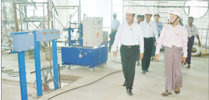
ထို့နောက် တိုင်းဒေသကြီးဝန်ကြီးချုပ်နှင့် အဖွဲ့သည် ကွန်ကရစ်ပိုက်များဖြင့် ရေလွင်းစနစ် တည်ဆောက်နေမှုလုပ်ငန်း၊ စပါးခွံလောင်စာသုံးလျှပ်စစ်ဓာတ်အား ထုတ်လုပ်နိုင်ရေးလုပ်ငန်းနှင့် စပါးခွံသိုလှောင်ရုံတည်ဆောက်ပြီးစီးနေမှု အခြေအနေများကို ကြည့်ရှုစစ်ဆေးခဲ့ကြပြီး တိုင်းဒေသကြီးဝန်ကြီးချုပ်က ပေါင်းစပ်ဆောင်ရွက်ပေးခဲ့ကြောင်း သိရသည်။ တိုင်းဒေသကြီး(ပြန်/ဆက်)
