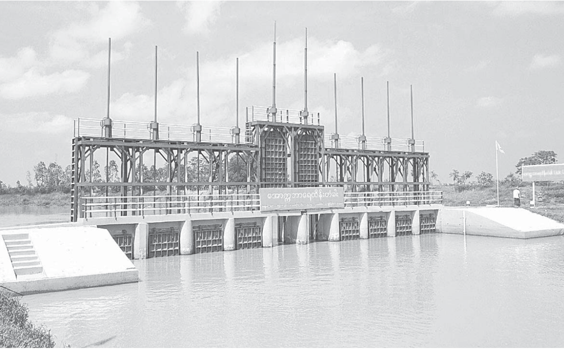
ပင်လယ်ရေငန်ကာကွယ်ခြင်း၊ ရေချိုသိုလှောင်ခြင်းနှင့် မိုးရာသီရေထုတ်နုတ်ခြင်းများကို ဆောင်ရွက်ပေးလျက်ရှိသော ဖျာပုံမြို့နယ် တောင်သူအကျိုးပြု အောက္ကဘာရေထိန်းတံခါးကိုတွေ့မြင်ရစဉ်။
