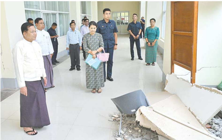
နိုင်ငံတော်စီမံအုပ်ချုပ်ရေးကောင်စီဥက္ကဋ္ဌ နိုင်ငံတော်ဝန်ကြီးချုပ် ဗိုလ်ချုပ်မှူးကြီးမင်းအောင်လှိုင် မန္တလေးငလျင်ကြီးကြောင့် အမျိုးသားစာကြည့်တိုက်(နေပြည်တော်)အဆောက်အဦ ထိခိုက်ပျက်စီးမှုကို ကြည့်ရှုစစ်ဆေးစဉ်။
