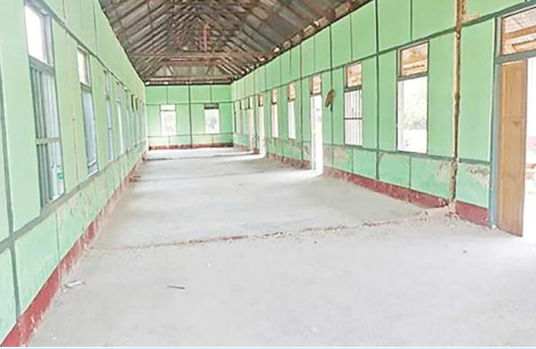
မန္တလေးငလျင်ကြီးလှုပ်ခတ်မှုကြောင့် ကျောက်ဆည်ခရိုင်အတွင်း ထိခိုက်ပျက်စီး သွားသော အခြေခံပညာအထက်တန်းကျောင်းပြိုကျပျက်စီးမှုအား ဖယ်ရှားရှင်းလင်း ဆောင်ရွက်ပြီးစီးမှုကိုတွေ့ရစဉ်။
