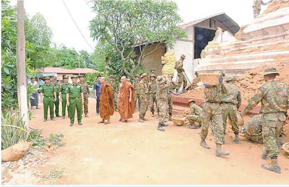
ကာကွယ်ရေးဦးစီးချုပ်ရုံး(ကြည်း)မှ ဒုတိယဗိုလ်ချုပ်ကြီးစိုးတင့်နိုင် မန္တလေးမြို့၊ အမရပူရမြို့နယ်ရှိ ရွှေကြက်ယက်ဆုတောင်းပြည့်မြတ်စွာဘုရား၌ ငလျင်ဒဏ်ကြောင့် ပြိုကျပျက်စီးခဲ့သည့် အပျက်အစီးများ အား ဖယ်ရှားရှင်းလင်းရေး ဆောင်ရွက်နေမှုကို ကြည့်ရှုစစ်ဆေးစဉ်။
