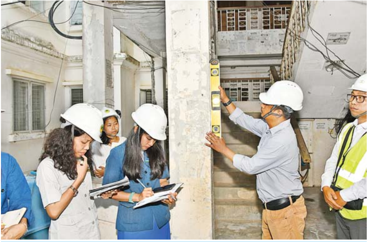
အနီရောင်အဆင့်သတ်မှတ်ထားသည့် ကုံကော်အိမ်ရာ တိုက်အမှတ်(၉)၌ နေပြည်တော်စည်ပင်သာယာရေးကော်မတီ၊ ဆောက်လုပ်ရေးဝန်ကြီးဌာနနှင့်မြန်မာ နိုင်ငံအင်ဂျင်နီယာကောင်စီတို့မှ ကျွမ်းကျင်ပညာရှင်များက အဆောက်အဦကြံ့ခိုင် ရေးတိုင်းတာသည့်စက်ကိရိယာ ၅ မျိုးဖြင့် အဆောက်အဦကြံ့ခိုင်မှုအား စစ်ဆေး နေမှုကို တွေ့ရစဉ်။
