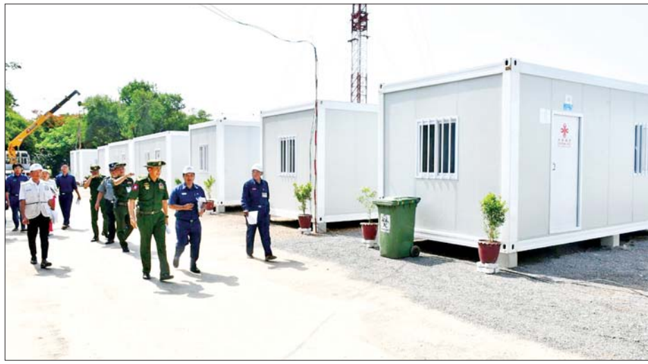
ကာကွယ်ရေးဦးစီးချုပ်ရုံး(ကြည်း)မှ ဒုတိယဗိုလ်ချုပ်ကြီး မျိုးမိုးအောင်နှင့် တာဝန်ရှိသူများ မန္တလေးမြို့တော်စည်ပင်သာယာရေးကော်မတီ စက်ရုံနှင့်မော်တော်ယာဉ်ဌာနရှိ လျှင်ဒဏ်သင့်ဝန်ထမ်းများအတွက် Modular Container House များ ဆောက်လုပ်ထားရှိမှုကို ကြည့်ရှုစစ်ဆေးစဉ်။
