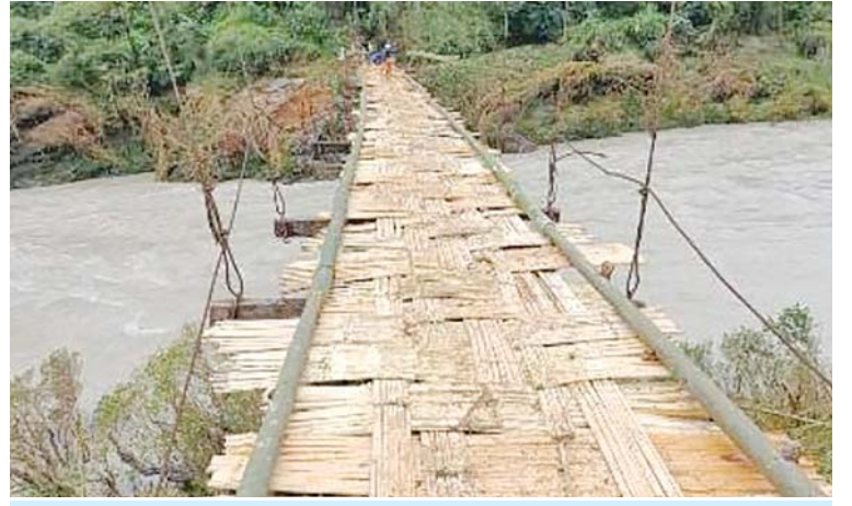
ပန်နန်းဒင်မေမြစ်ကူး(လူကူး)ကြိုးတံတား ပြန်လည်ဆောက်လုပ်ပြီးစီးမှုကို တွေ့ရစဉ်။
