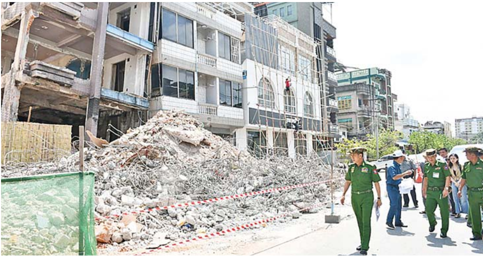
ကာကွယ်ရေးဦးစီးချုပ်ရုံး(ကြည်း)မှ ဒုတိယဗိုလ်ချုပ်ကြီးမျိုးမိုးအောင် မန္တလေးမြို့၊ မဟာအောင်မြေ မြို့နယ်၊ ရတနာဘုမ္မိအရှေ့ရပ်ကွက်ရှိ ငလျင်ဒဏ်ကြောင့်ထိခိုက်ပျက်စီးခဲ့သော အန္တရာယ်ရှိလူနေအဆောက် အအုံများတွင် ဖြိုချရှင်းလင်းရန်ကျန်အဆောက်အအုံများအား လုပ်ငန်းဆောင်ရွက်ရန်ပြင်ဆင်ထားရှိမှု အခြေအနေများနှင့် ဖြိုချပြီးအပျက်အစီးများ အပြီးသတ်ရှင်းလင်းနေမှုအခြေအနေများအား လိုက်လံ ကြည့်ရှုစစ်ဆေးစဉ်။
