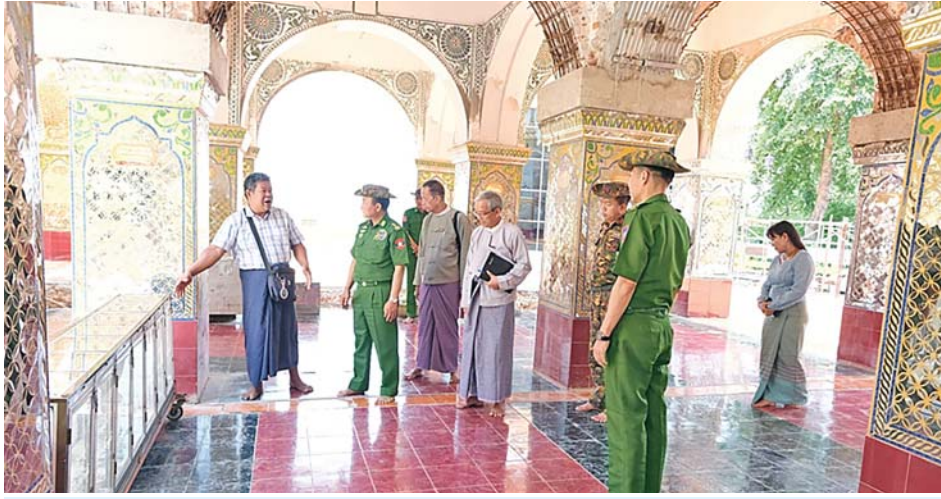
အောင်မြေသာစံမြို့နယ်၊ မန္တလေးတောင်တော်ရှိ ငလျင်ဒဏ်ကြောင့်ထိခိုက်ပျက်စီးခဲ့သည့် ဘုရားစေတီ များနှင့် သာသနိကအဆောက်အအုံများ၌ အပျက်အစီးများအား ဖယ်ရှားရှင်းလင်းခြင်းနှင့် ပြန်လည် ပြုပြင်တည်ဆောက်ခြင်းများ ဆောင်ရွက်နေမှုတို့ကို ကြည့်ရှုစစ်ဆေးစဉ်။
