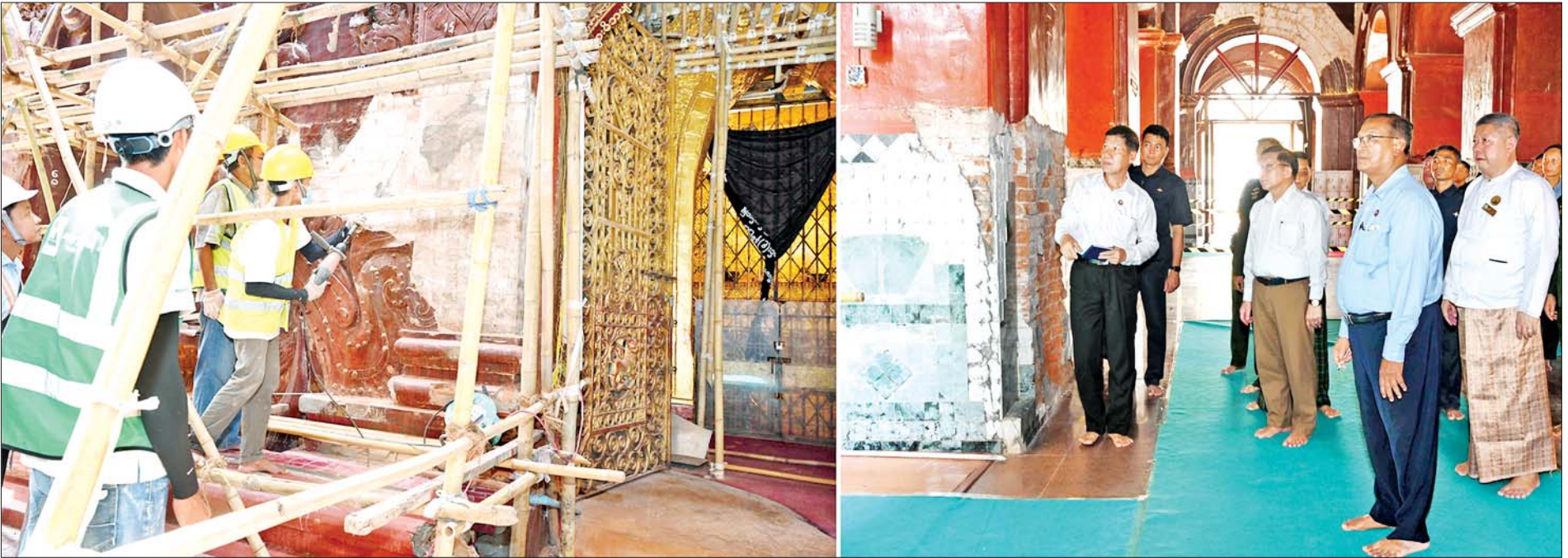
နိုင်ငံတော်စီမံအုပ်ချုပ်ရေးကောင်စီဥက္ကဋ္ဌ နိုင်ငံတော်ဝန်ကြီးချုပ် ဗိုလ်ချုပ်မှူးကြီးမင်းအောင်လှိုင် မန္တလေးမြို့ မဟာမြတ်မုနိဘုရားကြီးတွင် ငလျင်ဒဏ်ကြောင့် ထိခိုက်ပျက်စီးခဲ့ရမှုများနှင့် ပြန်လည်ပြုပြင်တည်ဆောက်လျက်ရှိသည့် အခြေအနေများကို ကြည့်ရှုစစ်ဆေးစဉ်။
