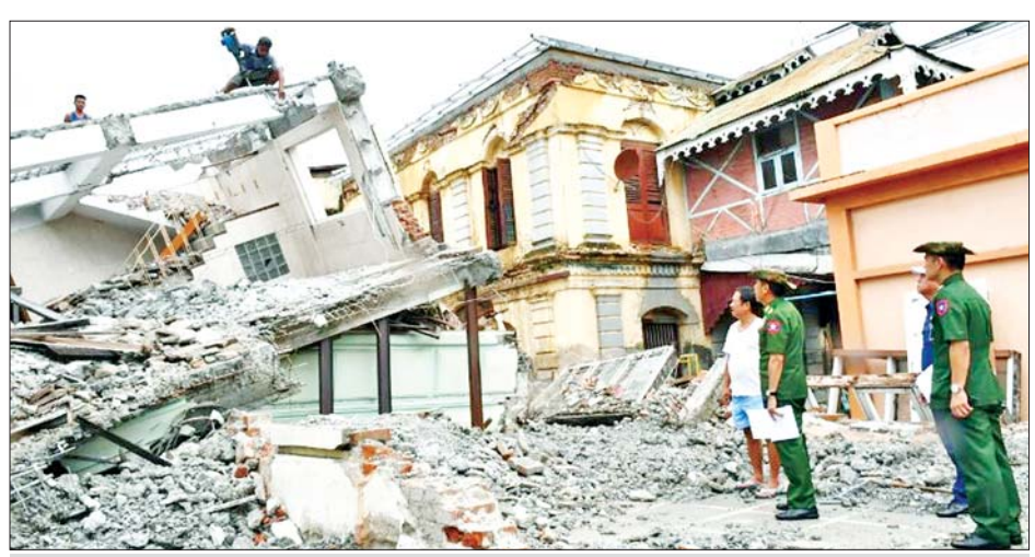
ကာကွယ်ရေးဦးစီးချုပ်ရုံး(ကြည်း)မှ ဒုတိယဗိုလ်ချုပ်ကြီး မျိုးမိုးအောင် မန္တလေးမြို့ မဟာအောင်မြေမြို့နယ်၊ ရပ်ကွက်များရှိ ငလျင်ဒဏ်ကြောင့် ထိခိုက်ပျက်စီးခဲ့သော အန္တရာယ်ရှိ လူနေအဆောက်အအုံများ ဖြိုချပြီး အပျက်အစီးများအပြီးသတ်ရှင်းလင်းနေမှုကို ကြည့်ရှုစစ်ဆေးစဉ်။
