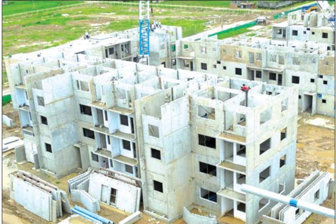
V-Pile Co နှင့် ရန်ကုန်မြို့တော်စည်ပင်သာယာရေးကော်မတီတို့ ပူးပေါင်းဆောင်ရွက်ခဲ့သော ‘ဗိုလ်ထူး’ အိမ်ရာစီမံကိန်း။
