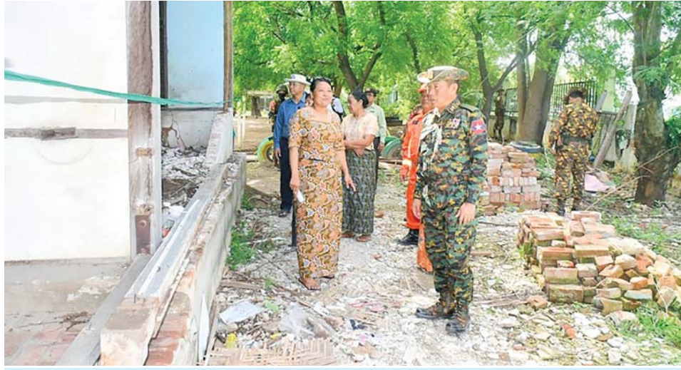
ကာကွယ်ရေးဦးစီးချုပ်ရုံး(ကြည်း)မှ ဒုတိယဗိုလ်ချုပ်ကြီးသက်ပုံ စစ်ကိုင်းမြို့နယ်အတွင်းရှိ ငလျင်ဒဏ်ကြောင့် ပြိုကျပျက်စီးခဲ့သော အခြေခံပညာအထက်တန်းကျောင်း(ခွဲ)စာသင်ကျောင်းဆောင်အပျက်အစီးများအား ဖယ်ရှားရှင်းလင်းနေမှုကိုကြည့်ရှုစစ်ဆေးစဉ်။
