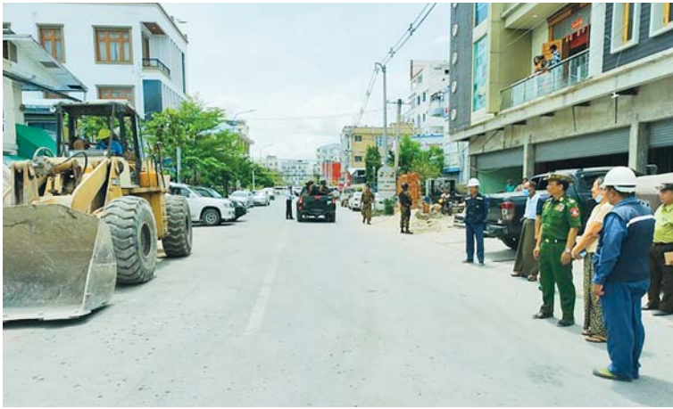
ကာကွယ်ရေးဦးစီးချုပ်ရုံး(ကြည်း)မှ ဒုတိယဗိုလ်ချုပ်ကြီးစိုးတင့်နိုင် မန္တလေးမြို့၊ ချမ်းမြသာစည်မြို့နယ် မြို့သစ်အမှတ်(၃)ရပ်ကွက်ရှိ အန္တရာယ်ရှိလူနေအဆောက်အအုံအပျက်အစီးများအား စက်ယန္တရားကြီးများအသုံးပြု၍ ရှင်းလင်းဖယ်ရှားနေမှုကို ကြည့်ရှုစစ်ဆေးစဉ်။
