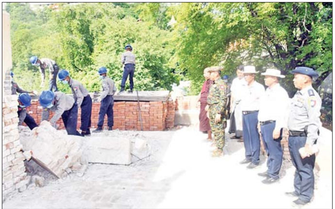
ကာကွယ်ရေးဦးစီးချုပ်ရုံး(ကြည်း) မှ ဒုတိယဗိုလ်ချုပ်ကြီးသက်ဝန် တောလေးထပ်ကျောင်းတိုက်ရှိ အပျက်အစီးများ ရှင်းလင်းနေမှု ကြည့်ရှုစစ်ဆေးစဉ်။
