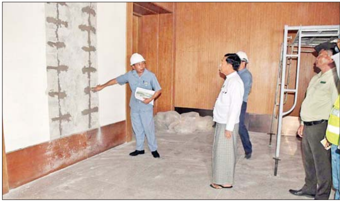
လှည့်လည်ကြည့်ရှုစစ်ဆေးပြီး လိုအပ်သည်များ သတင်းရရှိသည်။ ကို မှာကြားဖြည့်ဆည်း ဆောင်ရွက်ပေးခဲ့ကြောင်း ထွန်းလင်း(ဇေယျာမြေ)
