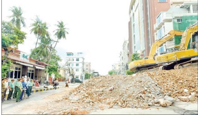
ကာကွယ်ရေးဦးစီးချုပ်ရုံး(ကြည်း)မှ ဒုတိယဗိုလ်ချုပ်ကြီး စိုးတင်နိုင် မန္တလေးမြို့ အောင်မြေသာစံမြို့နယ် ပြည်ကြီးကျက်သရေအနောက်ရပ်ကွက်ရှိ အန္တရာယ်ရှိ အဆောက်အအုံကို စက်ယန္တရားကြီးများအသုံးပြု၍ အပြီးသတ်ဖယ်ရှားရင်းလင်းနေမှု ကြည့်ရှုစစ်ဆေးစဉ်။
