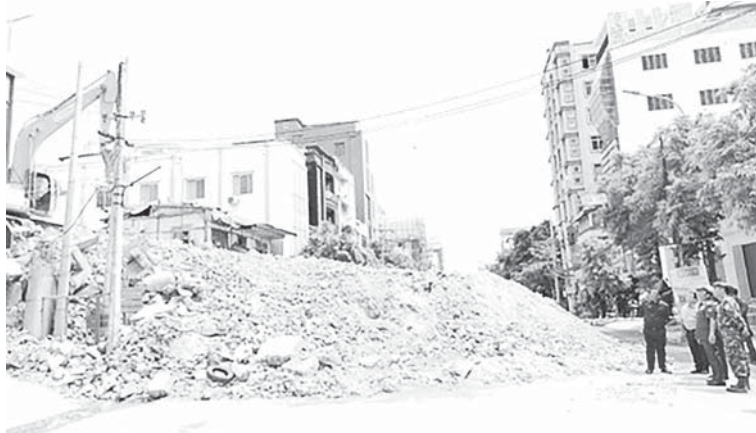
ကာကွယ်ရေးဦးစီးချုပ်ရုံး(ကြည်း)မှ ဒုတိယဗိုလ်ချုပ်ကြီးစိုးတင်နိုင် ငလျင်ဒဏ်ကြောင့် ပြိုကျပျက်စီးခဲ့သည့် ချမ်းအေးသာစံမြို့နယ် အောက်နန်းရိပ်သာအရှေ့ရပ်ကွက်၌ အန္တရာယ်ရှိအဆောက်အအုံအပျက်အစီးများအား စက်ယန္တရားကြီးများ အသုံးပြု၍ ရှင်းလင်းနေမှုကိုကြည့်ရှုစစ်ဆေးစဉ်။
