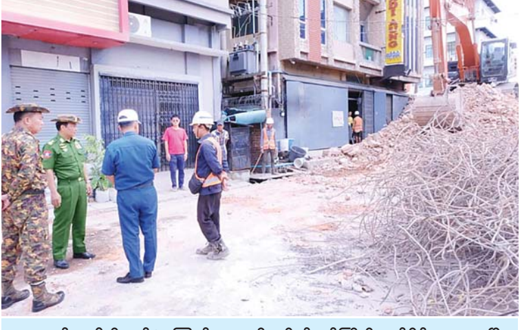
ကာကွယ်ရေးဦးစီးချုပ်ရုံး(ကြည်း)မှ ဒုတိယဗိုလ်ချုပ်ကြီးစိုးတင်နိုင် မန္တလေးမြို့၊ မဟာအောင်မြေမြို့နယ်၊ မဟာမြိုင်ရပ်ကွက်ရှိ လျင်ဒဏ်ကြောင့် ပြိုကျပျက်စီးခဲ့သော အန္တရာယ်ရှိအဆောက်အအုံအပျက်အစီးများအား စက်ယန္တရားကြီးများ အသုံးပြု၍ အပြီးသတ်ဖယ်ရှားရှင်းလင်းနေမှုကို ကြည့်ရှုစစ်ဆေးစဉ်။
