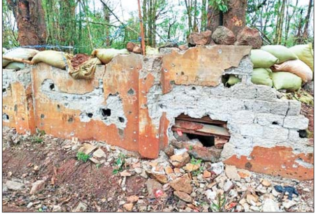
အဆောက်အအုံ အုတ်တံတိုင်းများဖောက်၍ ပစ်ကျင်း/ခံစစ်ပြုလုပ်ထားမှု မှတ်တမ်းဓာတ်ပုံ။
