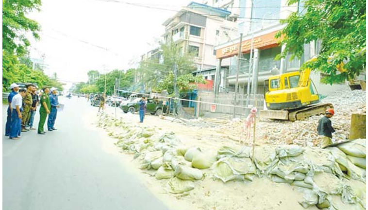
ကာကွယ်ရေးဦးစီးချုပ်ရုံး(ကြည်း)မှ ဒုတိယဗိုလ်ချုပ်ကြီးစိုးတင့်နိုင် ရတနာဘုမ္မိအနောက်ရပ်ကွက်၌ ငလျင်ဒဏ်ကြောင့် ပြိုကျပျက်စီးခဲ့သော အန္တရာယ်ရှိအဆောက်အအုံအပျက်အစီးများအား စက်ယန္တရားကြီးများအသုံးပြု၍ အပြီးသတ်ဖယ်ရှားရှင်းလင်းနေမှုကို ကြည့်ရှုစစ်ဆေးစဉ်။
