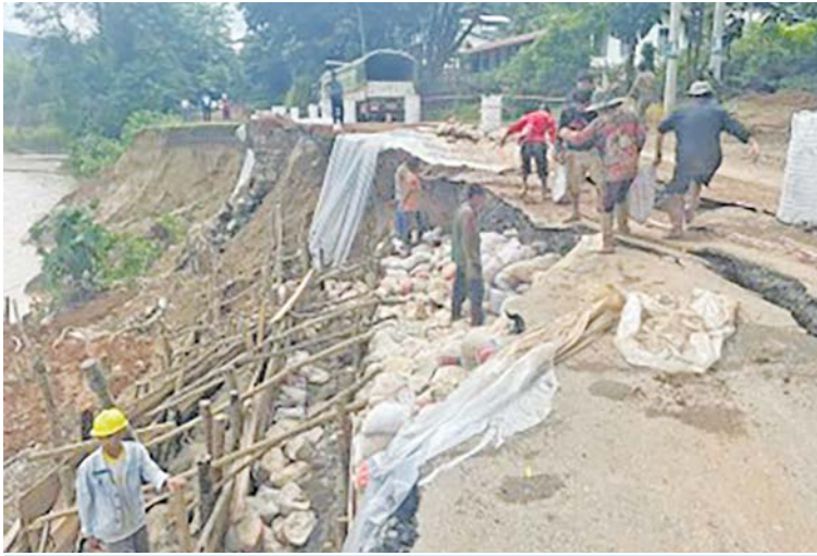
ရှမ်းပြည်နယ်(အရှေ့ပိုင်း)၊ တုံတာမြို့၌ ချောင်းရေတိုက်စားမှုကြောင့် လမ်းပန်းသား/ လမ်းသားပဲ့ကျမှုအား ပြန်လည်ပြုပြင်ဆောင်ရွက်စဉ်။
