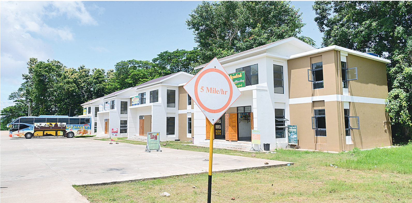
အောင်လံမြို့အဝေးပြေးယာဉ်ရပ်နားစခန်း အဆင့်မြင့်တင်တည်ဆောက်ထားရှိမှုကို တွေ့ရစဉ်။
