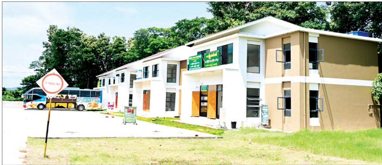
အောင်လံမြို့ အဝေးပြေးယာဉ်ရပ်နားစခန်းအဆင့်မြှင့်တင်တည်ဆောက်ထားရှိမှုကို တွေ့ရစဉ်။
