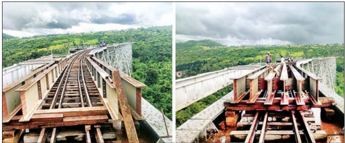
ပျက်စီးသွားသော သံပေါင်အဆက်နေရာမှ ပေ ၃၀ ဖြတ်ထုတ်ဖယ်ရှားပြီး Way Beam သံပေါင်အား ထည့်သွင်းတပ်ဆင်ရန် ပြင်ဆင်ဆောင်ရွက်ဆဲဓာတ်ပုံမှတ်တမ်း။
