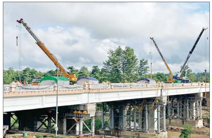
ငလျင်ဒဏ်ကြောင့် ထိခိုက်ပျက်စီးခဲ့သည့် လွှတ်တော်အဝင် အမှတ် (၁) တံတားအား ခေတ်မီနည်းပညာ များဖြင့် ပြုပြင်ဆောင်ရွက်နေမှုကို တွေ့ရစဉ်။
