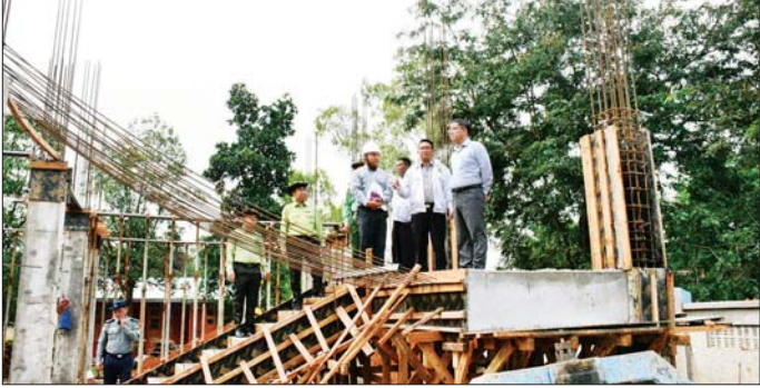
သံကွက်ကရစ် အဆောက်အအုံတည်ဆောက်နေမှုကို ကြည့်ရှုစစ်ဆေးကာ လုပ်ငန်းများ သတ်မှတ်အရည်အသွေး ပြည့်မီစွာဖြင့် ရှိသူများအား မှာကြားခဲ့ကြောင်း သတိပေးသည်။
