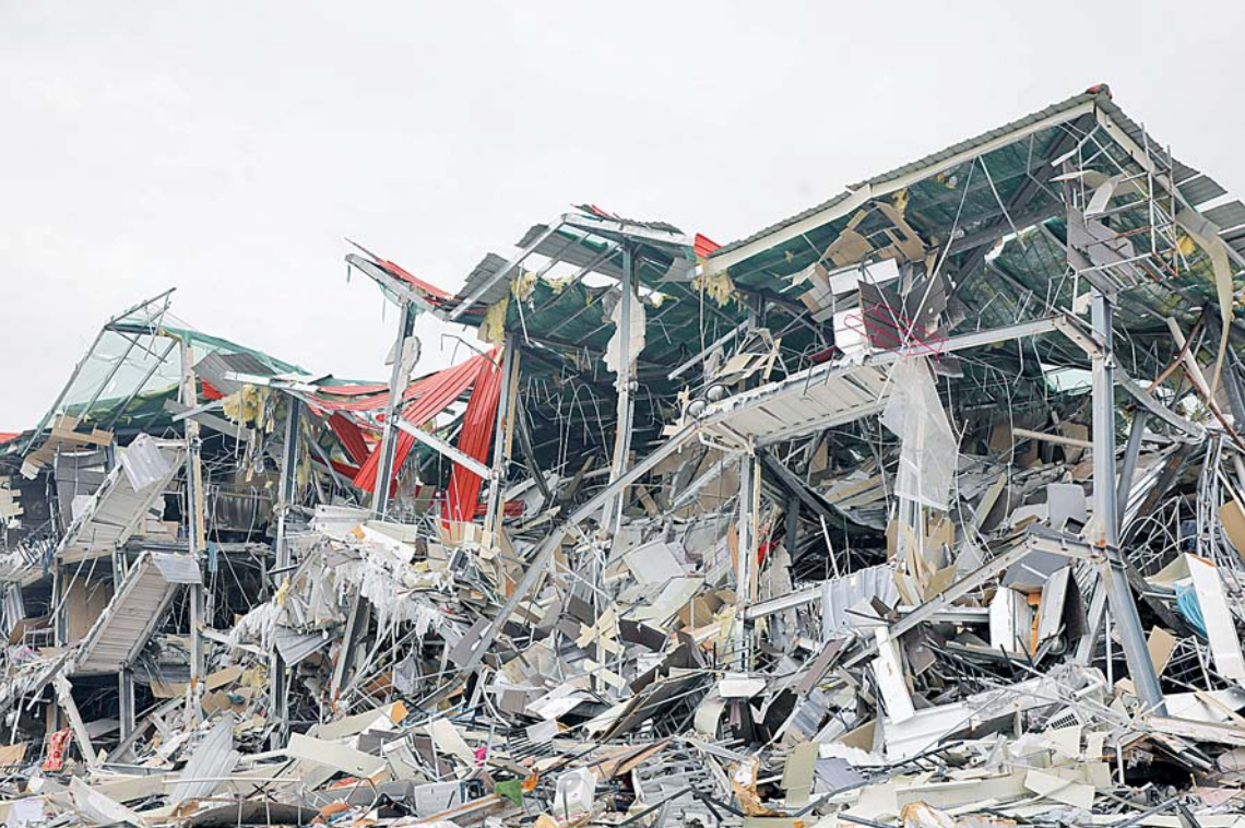
မြဝတီ-မဲ့ထော်သလေး KK Park နယ်မြေအတွင်းရှိ အဆောက်အအုံများ ဖြိုချဖျက်ဆီးရှင်းလင်းနေမှုကိုတွေ့ရစဉ်။
