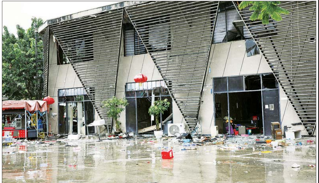
မြဝတီ-မှထောင်သလေး KK Park နယ်မြေအတွင်းရှိ ဖြိုဖျက်ဆီးရှင်းလင်းမည့် အဆောက်အအုံအား တွေ့ရစဉ်။
