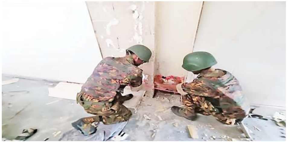
လူနေအဆောက်အအုံ(၄)ထပ် C 3 အားဖောက်ခွဲရန် ယမ်းများတပ်ဆင်နေမှုကို တွေ့ရစဉ်။
