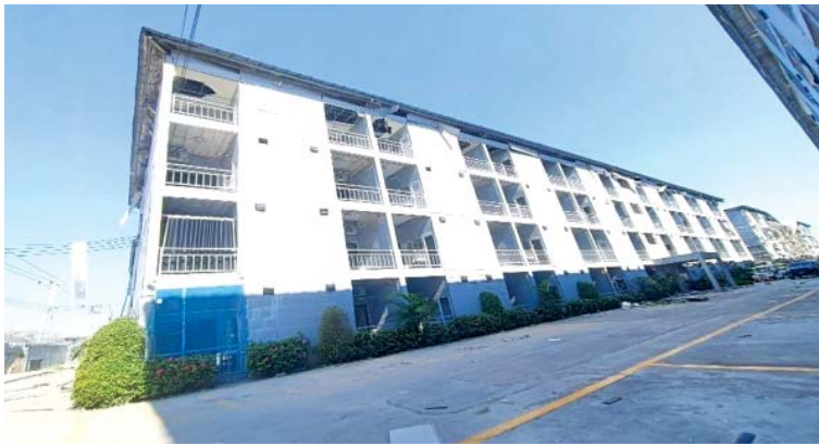
လူနေအဆောက်အအုံ (၄)ထပ် G2 အား မဖောက်ခွဲမီမြင်တွေ့ရစဉ်။
