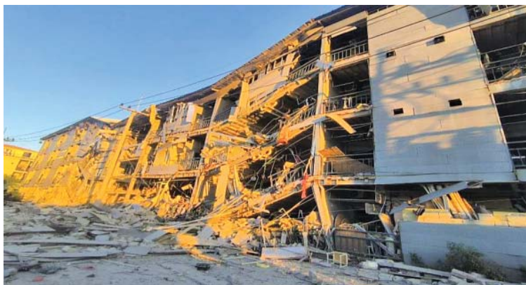
လူနေအဆောက်အအုံ (၄)ထပ် C1 အား ဖောက်ခွဲဖျက်ဆီးပြီးမြင်တွေ့ရစဉ်။
