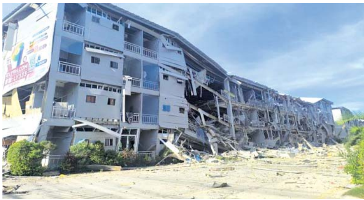
လူနေအဆောက်အအုံ (၄)ထပ် G2 အား ဖောက်ခွဲဖျက်ဆီးပြီးမြင်တွေ့ရစဉ်။
