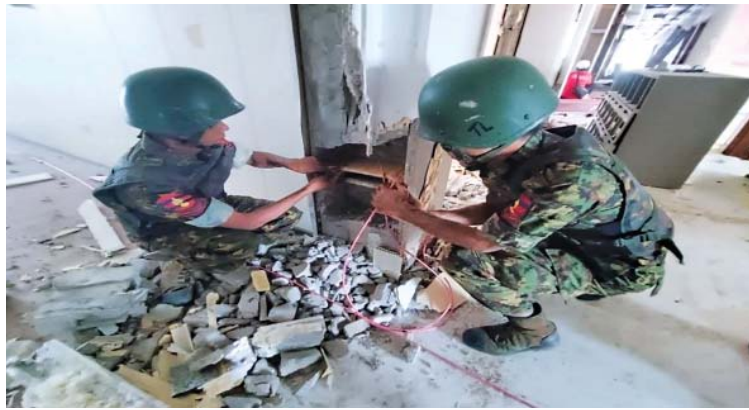
လူနေအဆောက်အအုံ (၄)ထပ် G2 အား ဖောက်ခွဲရန်ယမ်းများတပ်ဆင်နေမှုကို တွေ့ရစဉ်။
