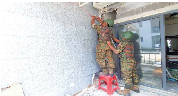
လူနေအဆောက်အအုံ (၄)ထပ် C1 အား ဖောက်ခွဲရန် ယမ်းများတပ်ဆင်နေမှုကို တွေ့ရစဉ်။
