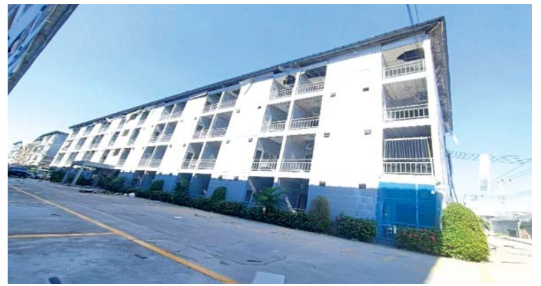
လူနေအဆောက်အအုံ (၄)ထပ် C1 အား မဖောက်ခွဲမီ မြင်တွေ့ရစဉ်။
