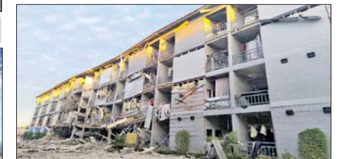
KK Park အတွင်း လူနေအဆောက်အအုံ လေးထပ် C9 ကို မဖောက်ခွဲမီနှင့် ဖောက်ခွဲပြီး မြင်တွေ့ရစဉ်။
