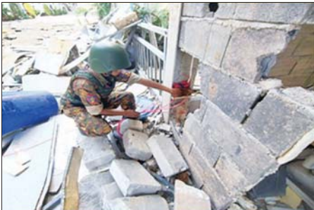
လူနေအဆောက်အအုံ ငါးထပ် C 13 အား ဖောက်ခွဲဖျက်ဆီးရန် ယမ်း ၁၆၀ ကီလိုဂရမ်တပ်ဆင်နေစဉ်။
