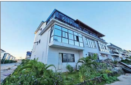
ယန္တရားဖြင့် ဖြိုဖျက်မည့် သုံးထပ်လူနေအဆောက်အအုံများအား မြင်တွေ့ရစဉ်။
