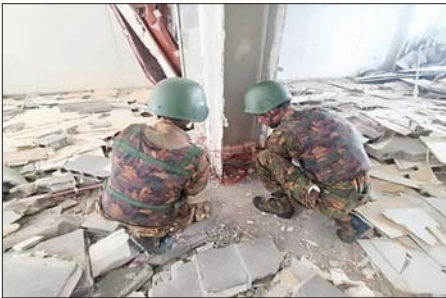
လူနေအဆောက်အအုံ ငါးထပ် C 18 အား ဖောက်ခွဲဖျက်ဆီးရန် ယမ်း ၁၆၀ ကီလိုဂရမ်တပ်ဆင်နေစဉ်။
