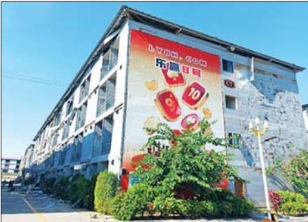
လူနေအဆောက်အအုံ လေးထပ် C 7 အား မြင်တွေ့ရစဉ်။
