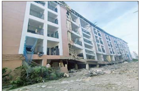
လူနေအဆောက်အအုံ ငါးထပ်တိုက် အမှတ် C 13 အား စနစ်တကျ ဖောက်ခွဲဖျက်ဆီးပြီး မြင်တွေ့ရစဉ်။
