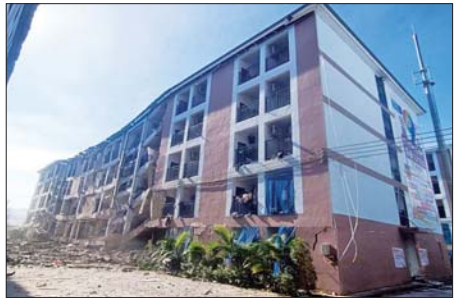
လူနေအဆောက်အအုံ ငါးထပ်တိုက် အမှတ် C 18 အား စနစ်တကျ ဖောက်ခွဲဖျက်ဆီးပြီး မြင်တွေ့ရစဉ်။
