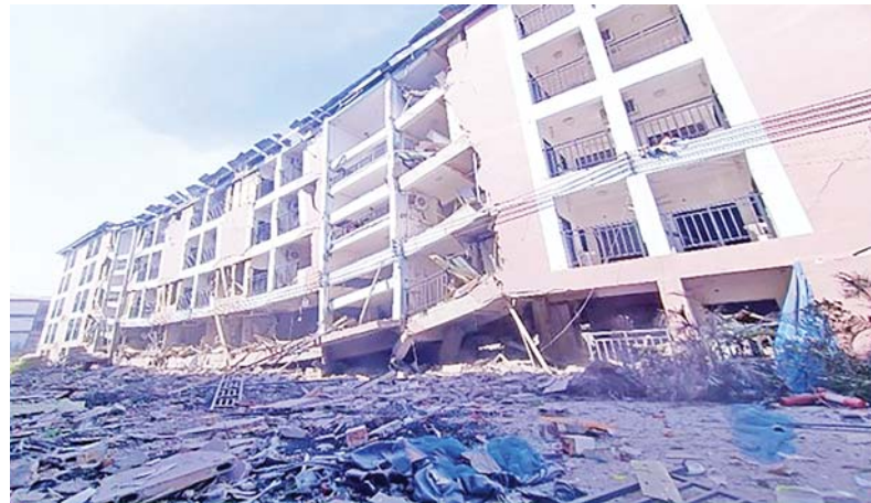
လူနေအဆောက်အအုံ (၅)ထပ်တိုက်အား ဖောက်ခွဲဖျက်ဆီးပြီးစီးမှုကိုတွေ့ရစဉ်။
