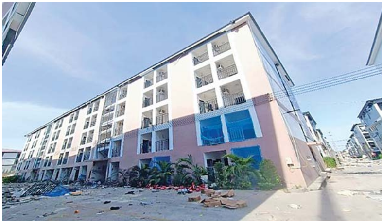
လူနေအဆောက်အအုံ (၅)ထပ်တိုက်အား မဖောက်ခွဲမီတွေ့ရစဉ်။
