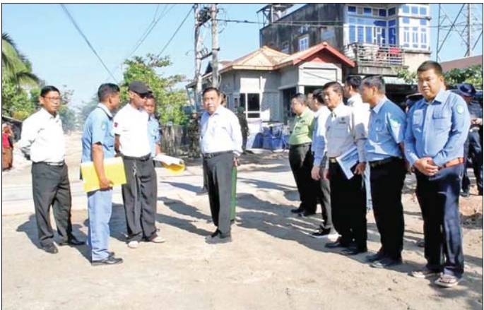
ထို့နောက် တိုင်းဒေသကြီးဝန်ကြီးချုပ်သည် ဗျောတောဝရပ်ကွက် မျှောအင်းလမ်းသွယ်(ပေ ၉၅၀ x ၁၂ ပေ) ကွန်ကရစ်ခင်းခြင်း လုပ်ငန်းဆောင်ရွက် နေမှုကို ကြည့်ရှုစစ်ဆေးပြီး ရပ်ကွက်နေပြည်သူများ အား ရင်းရင်းနှီးနှီး လိုက်လံနှုတ်ဆက်ကာ ရပ်ကွက် နေပြည်သူများ ကျန်းမာရေးအပြင် လူမှုစီးပွားဘဝ
