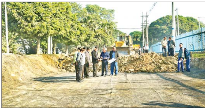
ဖယ်ရှား၍ လမ်းအောက်ခံမြေသား သတ်မှတ်ရာခိုင်နှုန်းရရှိရန် အလွှာလိုက်ခင်းကြိုတင်ခြင်း၊ Liquefaction၊ Sand Boil နှင့် Ground Crack ဖြစ်ပေါ်နေသော အပိုင်းများတွင် မြေသားအားဖြည့်သတင်းစဉ်
