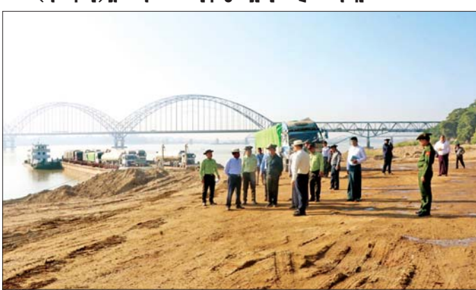
ပျက်စီးခဲ့သည့် စစ်ကိုင်းတိုင်းဒေသ ကြီး အဝင်မုခ်ဦး ပြန်လည် တည်ဆောက်နေမှုကို လည်း ကောင်း၊ စစ်ကိုင်းမြို့ဝင် ရောဝတီ လည်းကောင်း ကြည့်ရှုစစ်ဆေးပြီး လုံခြုံရေးဆိုင်ရာ ကိစ္စရပ်များ၊ တရားမဝင် ငွေကြေးကောက်ခံမှု များမရှိစေရေးနှင့် တရားမဝင်
