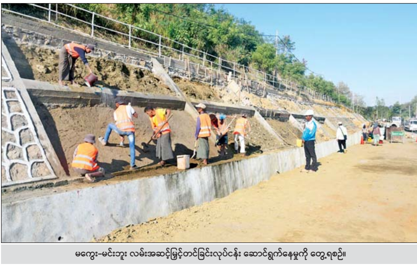
မကွေး-မင်းဘူး လမ်းအဆင့်မြှင့်တင်ခြင်းလုပ်ငန်း ဆောင်ရွက်နေမှုကို တွေ့ရစဉ်။
